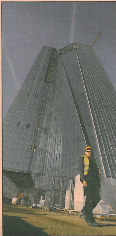
Im Zentrum der Baustelle Bankenunion: die EZB. Foto: Reuters
